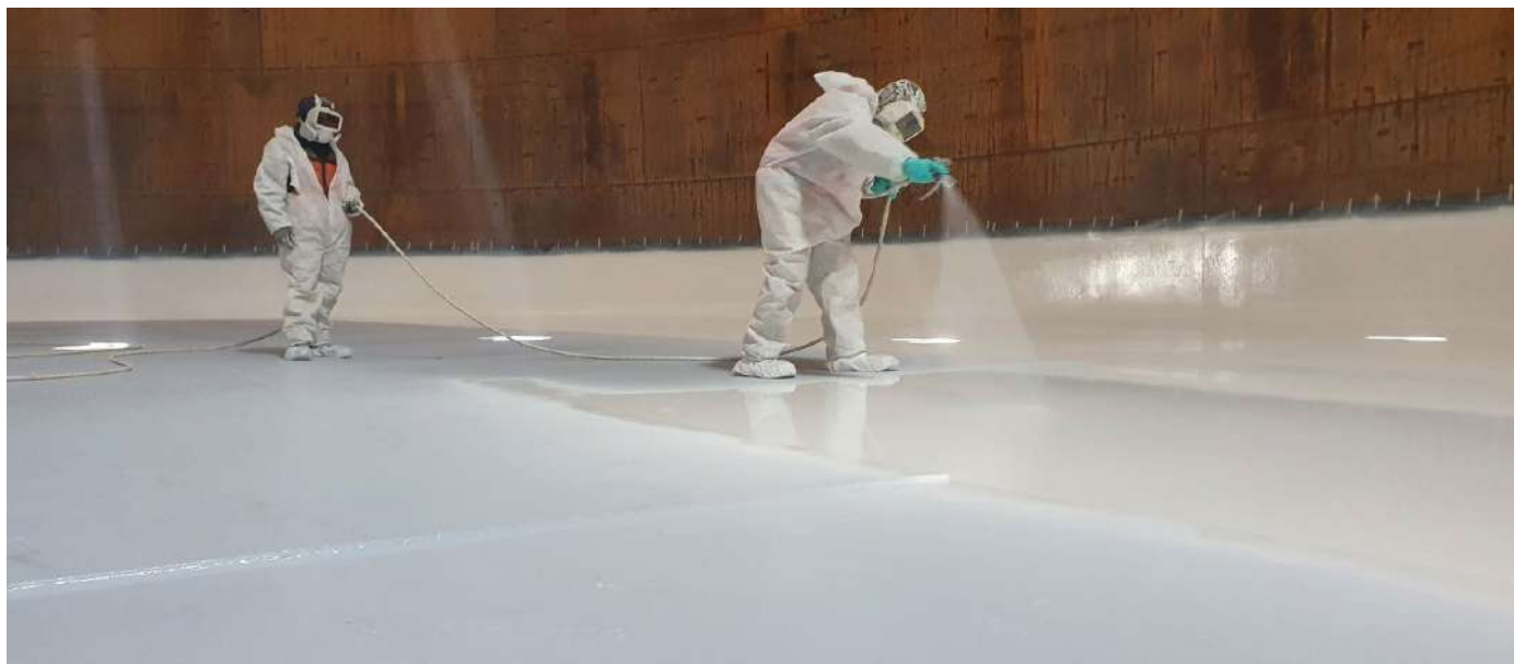
Aplicación de recubrimiento en exterior de tanques Terminal de Almacenamiento IENOVA Puebla.
