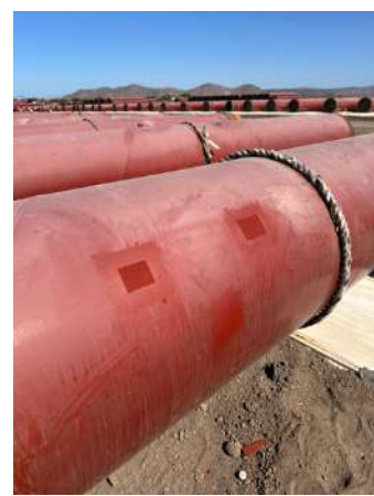
Reparación de golpes en tubos para conduccion de gas acopio Empalme Sonora. SP 8888.
