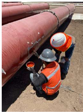
Reparación de golpes en tubos para conduccion de gas acopio Empalme Sonora. SP 8888.
